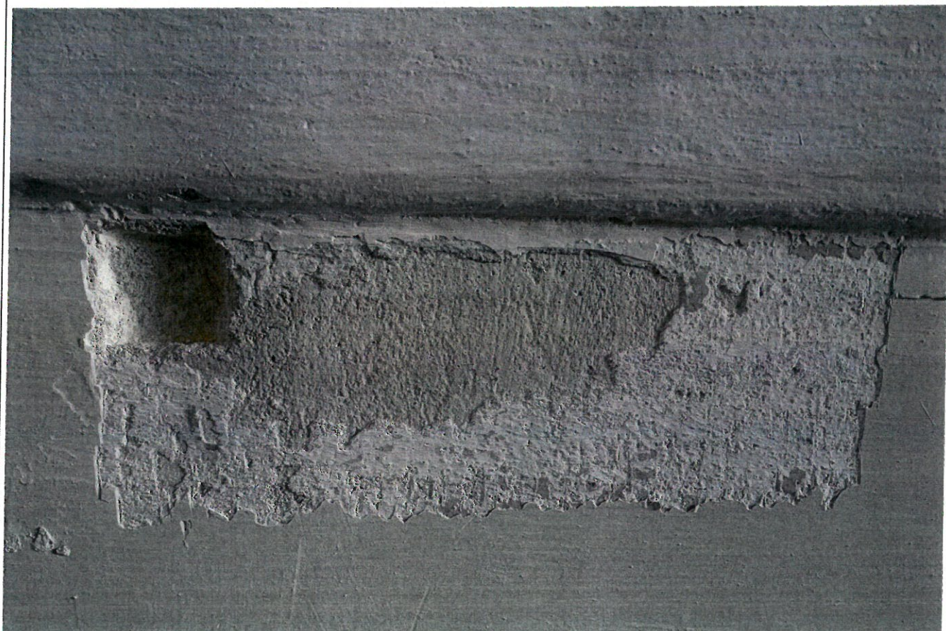
Siemiatycze. Kościół parafialny pw. Wniebowzięcia NMP. Badania kolorystyki wnętrza. Odkrywka w blendzie nad arkadą międzynawową. Fot. Andrzej Lewandowski. Czerwiec 2017.
