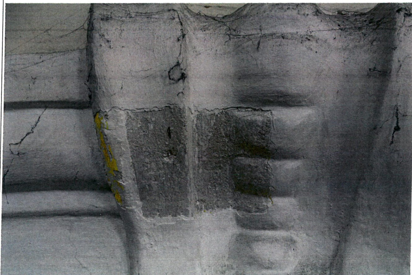
Siemiatycze. Kościół parafialny pw. Wniebowzięcia NMP. Badania kolorystyki wnętrza. Odkrywka na zworniku/kluczu arkady międzynawowej. Fot. Andrzej Lewandowski. Czerwiec 2017
